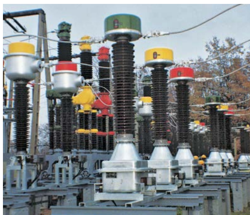
1. Transformadores de tensión inductivos de 123 kV (Bosnia).
