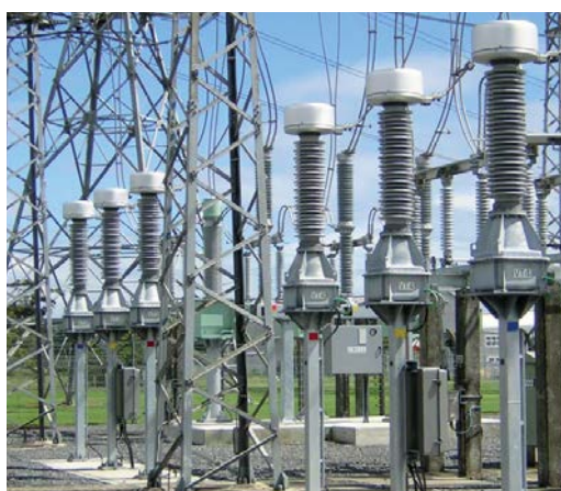
2. Transformadores de tensión inductivos de 123 kV. Transpower (Nueva Zelanda).
