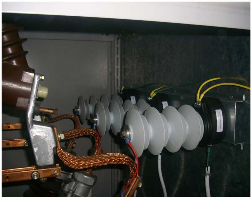
› Sensor de tensão UNDERSENS instalado em subestação secundária isolada de ar.
