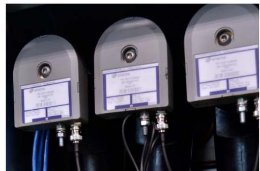
› Sensores de voltagem PLUGSENS Instalados em uma célula GIS.
