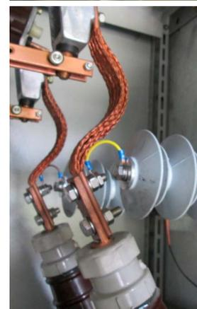
› Sensores de tensão em aparelhagem de isolamento de ar
