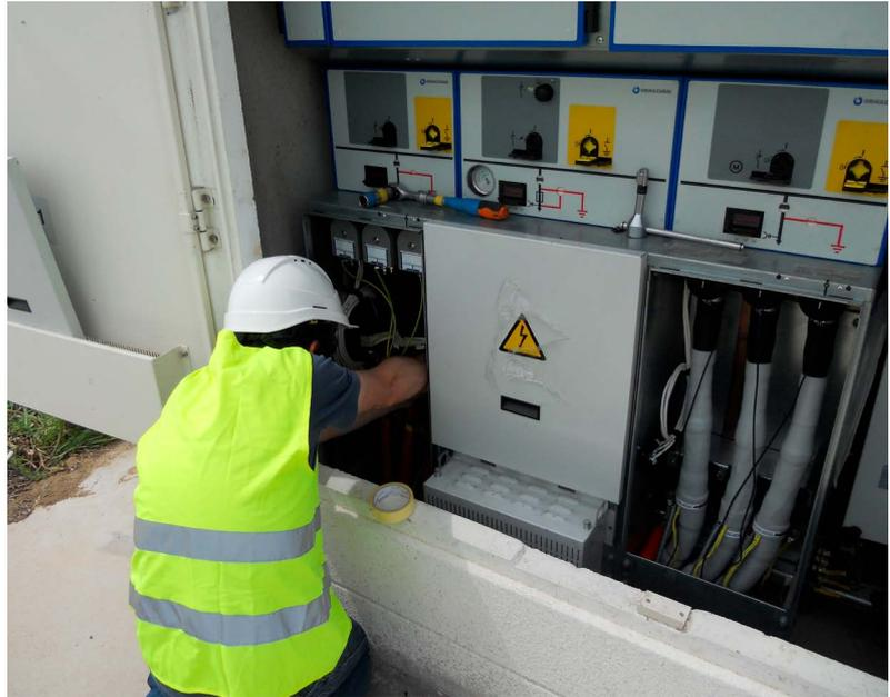
› Instalação duma nova subestação compacta GIS equipada com sensores de tensão e corrente.
