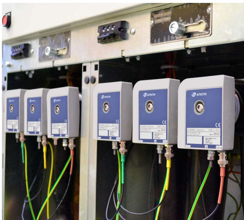
› Sensor de voltagem PLUGSENS e acoplador capacitivo PLUGCAP (BPL/PLC), instalación interior (GIS RMU).
